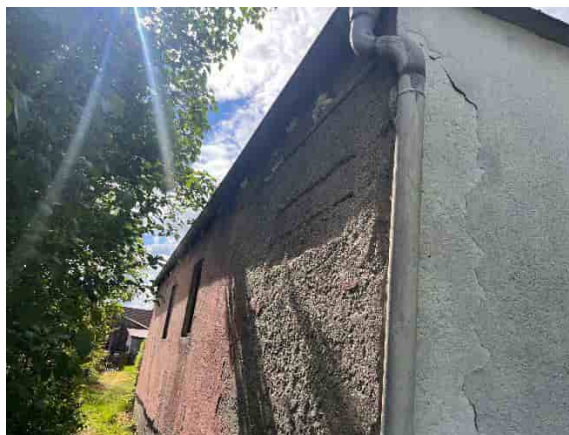
Abbildung 9: Mit Bauschaum ausgespritzte Fugen am Mauerwerk.
