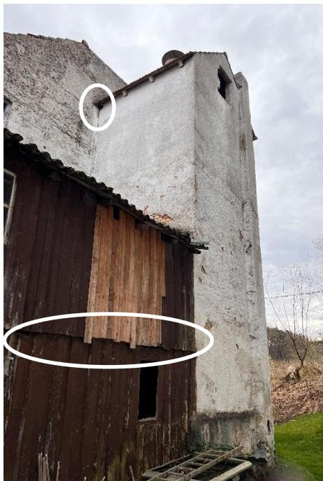
**Abbildung 10:** Pot. Spaltenstrukturen an Holzfassaden und am Mauerwerk.
