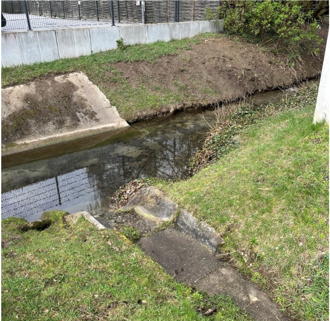
Abbildung 5: Einleitstelle am Lehenbach
