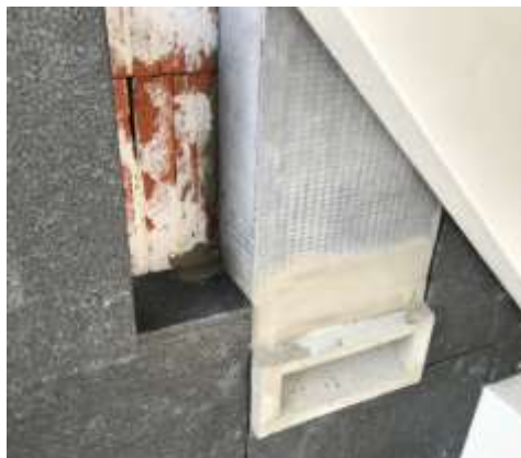
Abbildung 9: Ganzjahres Fassadennistkasten (Bildquelle: https://www.nistkasten-hasselfeldt.de/fledermaus-ganzjahres-fassadenkasten-unterputz-mit-blende ).
