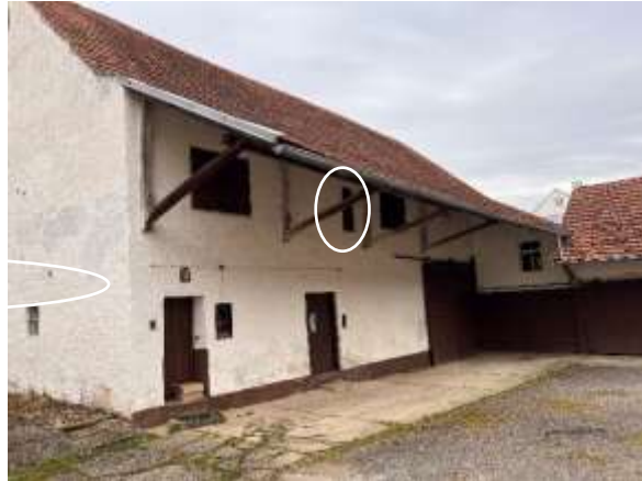
Abbildung 16: Nachgewiesene Ausflugsöffnung an Ostfassade des alten landwirtschaftl. Lagergebäudes (C).
