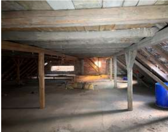
Abbildung 19: Ausleuchten des unteren Dachstuhls am Wohngebäude (A).
