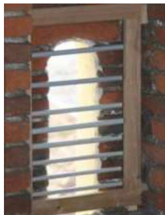
Abbildung 6: Rollstangen verhindern den Einflug von Tauben (Koordinationsstellen für Fledermausschutz Südbayern, 2020b)
