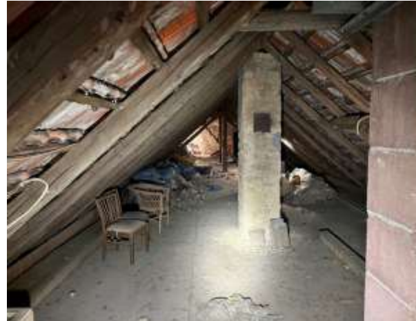
Abbildung 20: Ausleuchten des oberen Dachstuhls am Wohngebäude (A).
